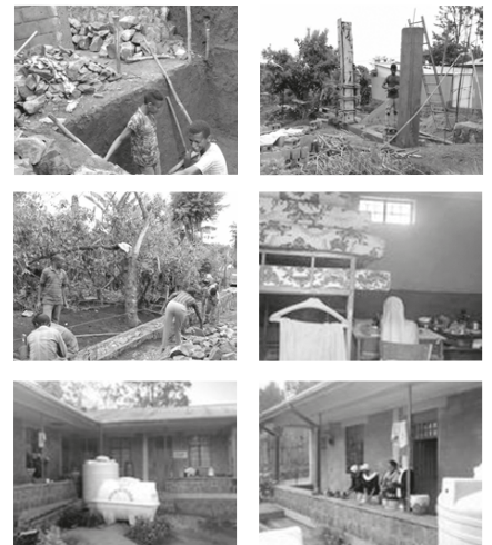
Eindrücke von den Umbauarbeiten
