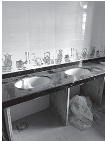
Die Waschbereiche und die Toiletten sind schon verputzt und die Sanitäreinrichtungen sind installiert.
